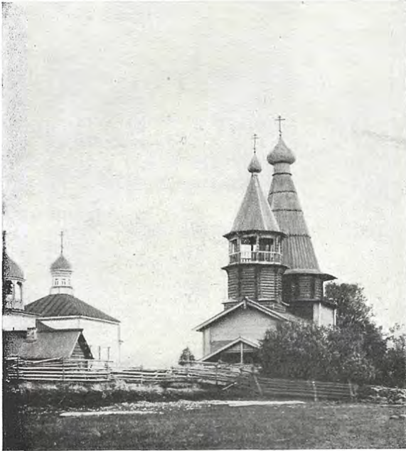
228. Вид с юго-запада
