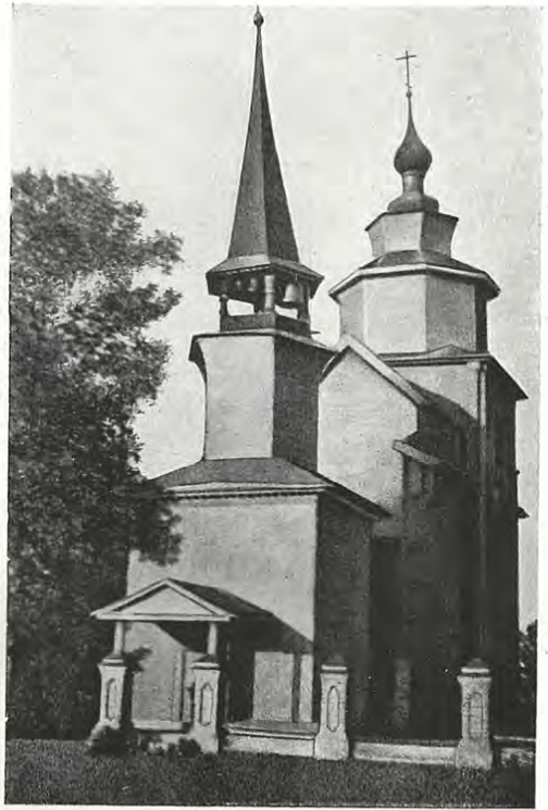
360. Общий вид церкви
