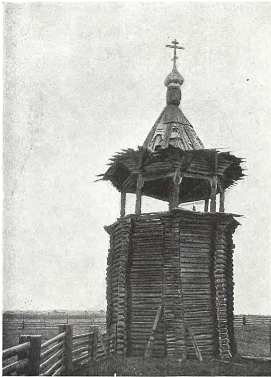
429. Общий вид колокольни
