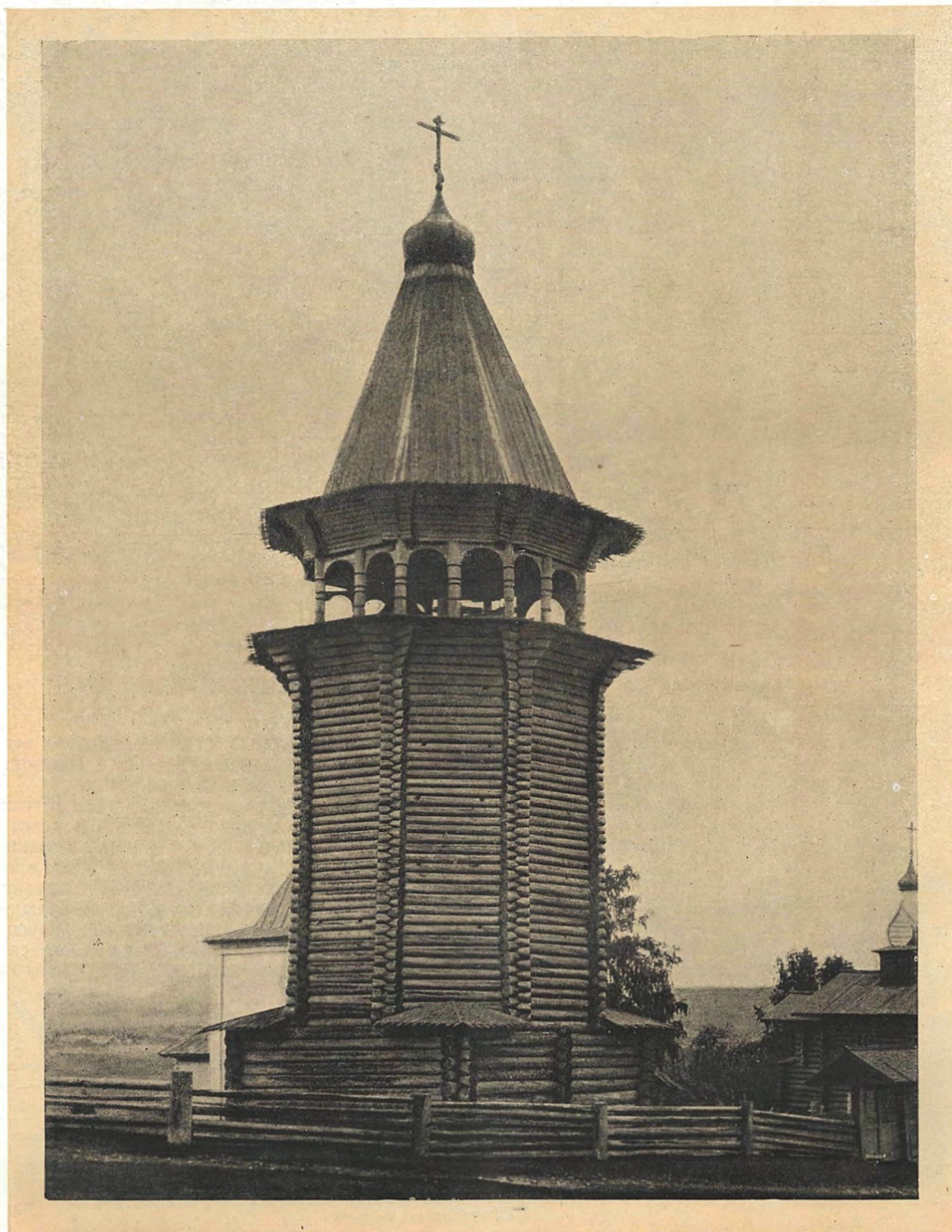
420. Общий вид колокольни
