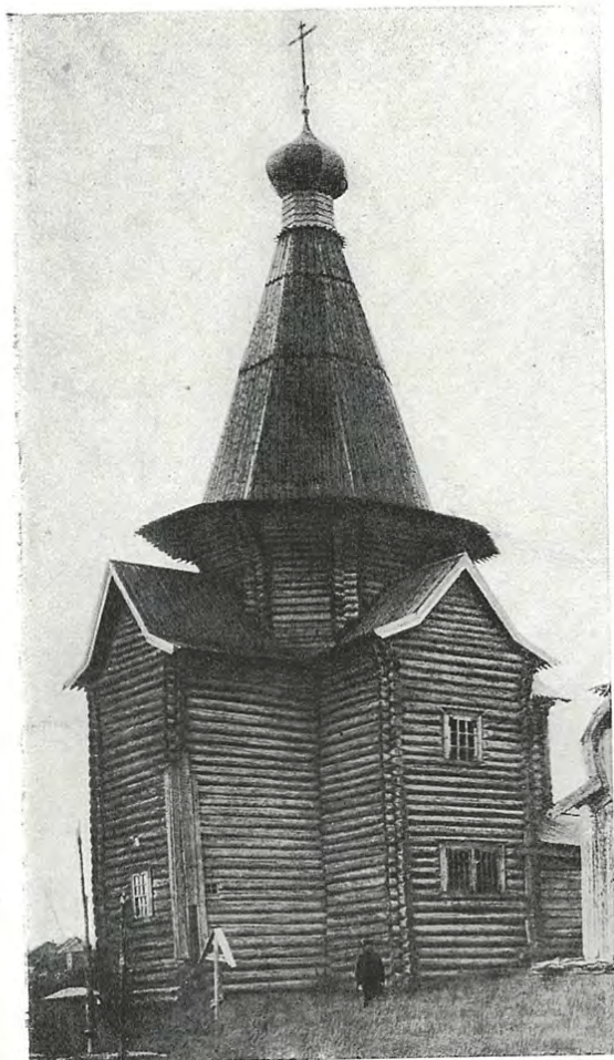
210. Вид церкви с северо-востока (до обшивки тесом)
