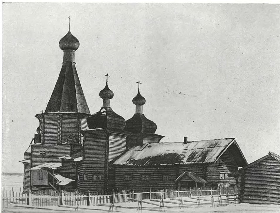
342. Вид церкви с северо-запада (до обшивки тесом)
