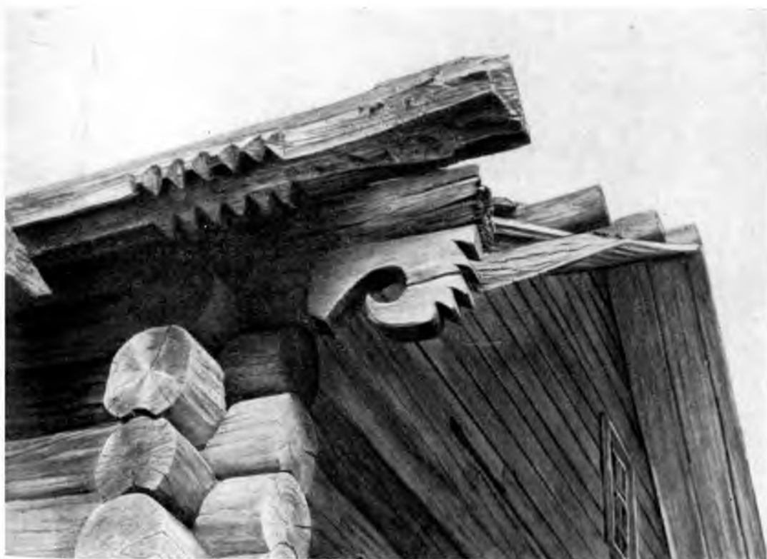
Фот. 63. Кронштейн и поток кровли дома в селе Долгощелье Мезенского района Архангельской области.
