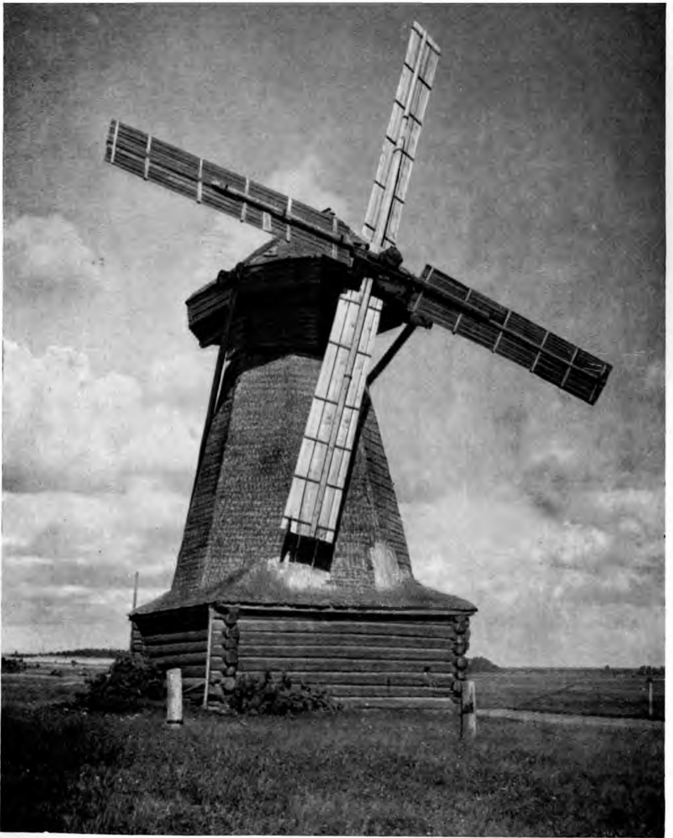
Фот. 136. Мельница в Юрьевоцком районе Ивановской области.
