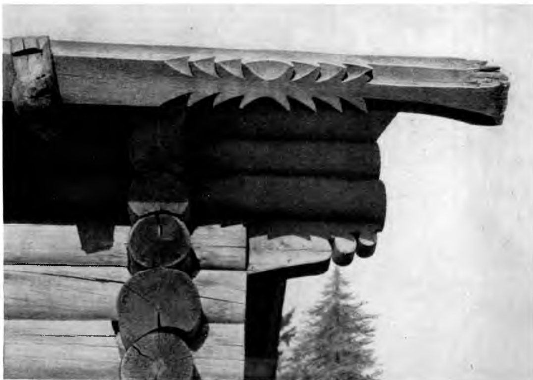
Фот. 62. Кронштейн и поток кровли дома в селе Перемень Карпогорского района Архангельской области.
