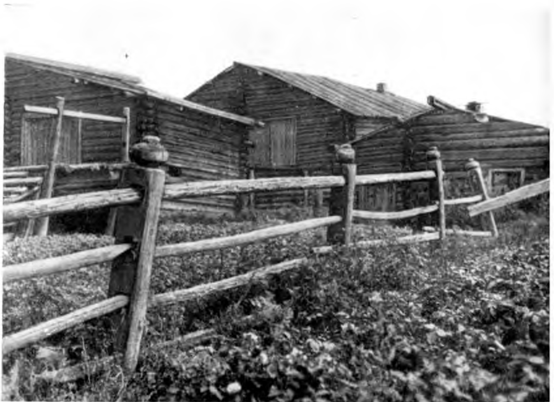
Фот. 87. Ограждение усадеб в селе Усть-Цильма Усть-Цильмского района Коми АССР.
