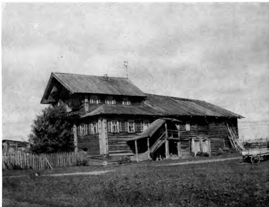
Фот. 22. Дом в селе Скребино Чарозерского района Вологодской области.
