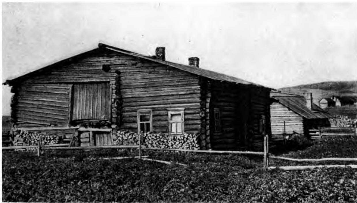
Фот. 31. Дом М. С. Чупровой в селе Усть-Цильма Усть-Цильмского района Коми АССР.
