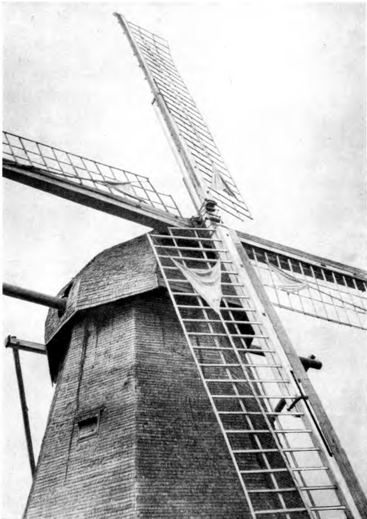
Фот. 135. Фрагмент мельницы близ села Курицкое Новгородского района Новгородской области.
