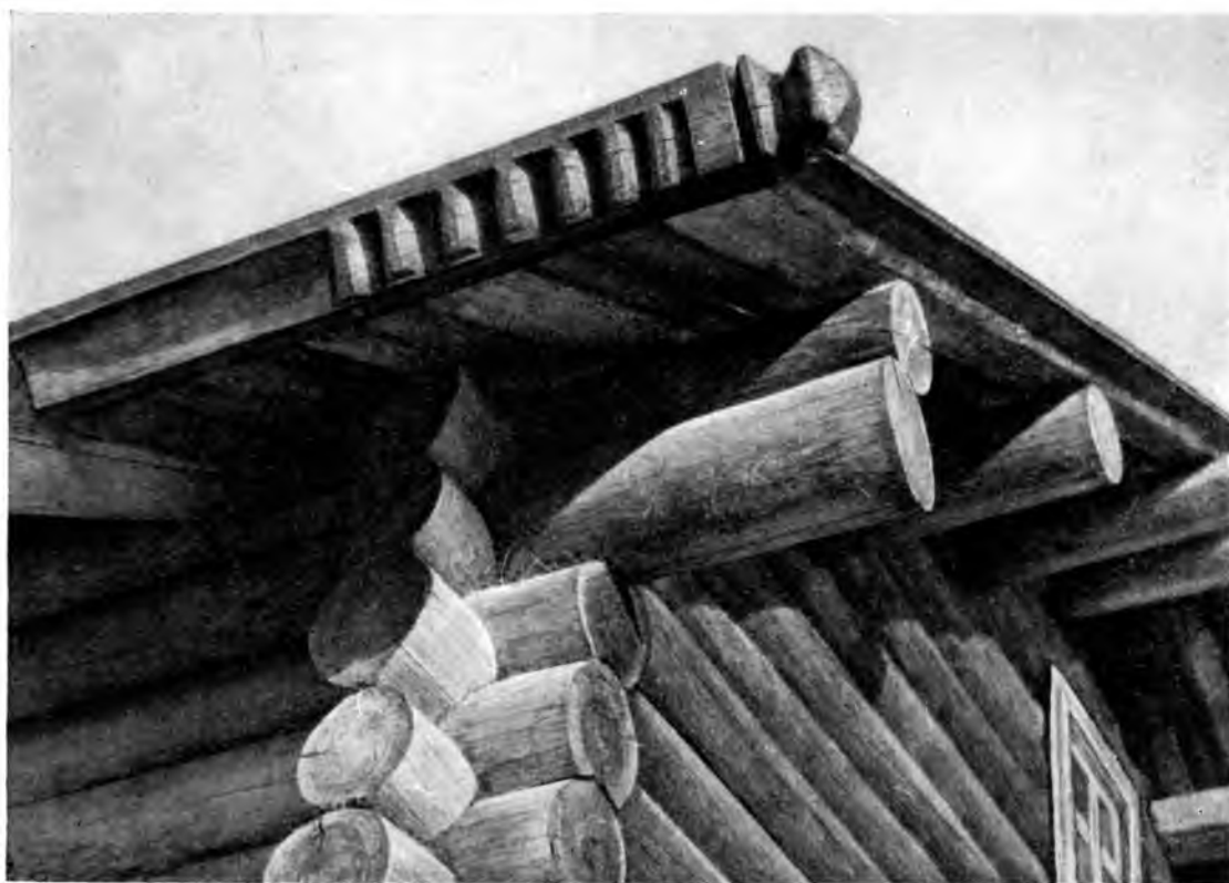
Фот. 65. Деталь кровли дома в селе Турчасово Плесецкого района Архангельской области.
