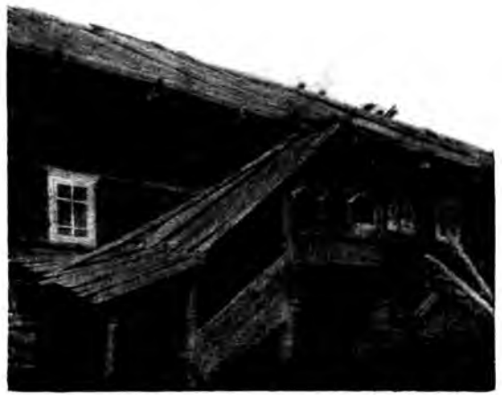
Рис. № 45 а. Крыльцо. По А. Бобринскому.
