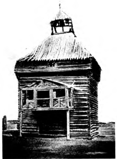
Рис. № 127. Проѣзжая башня Якутскаго острога. По Н. Султанову.
