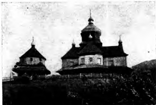
Рис. № 525. Церковь близъ Турки. По Н. Крюкову.
