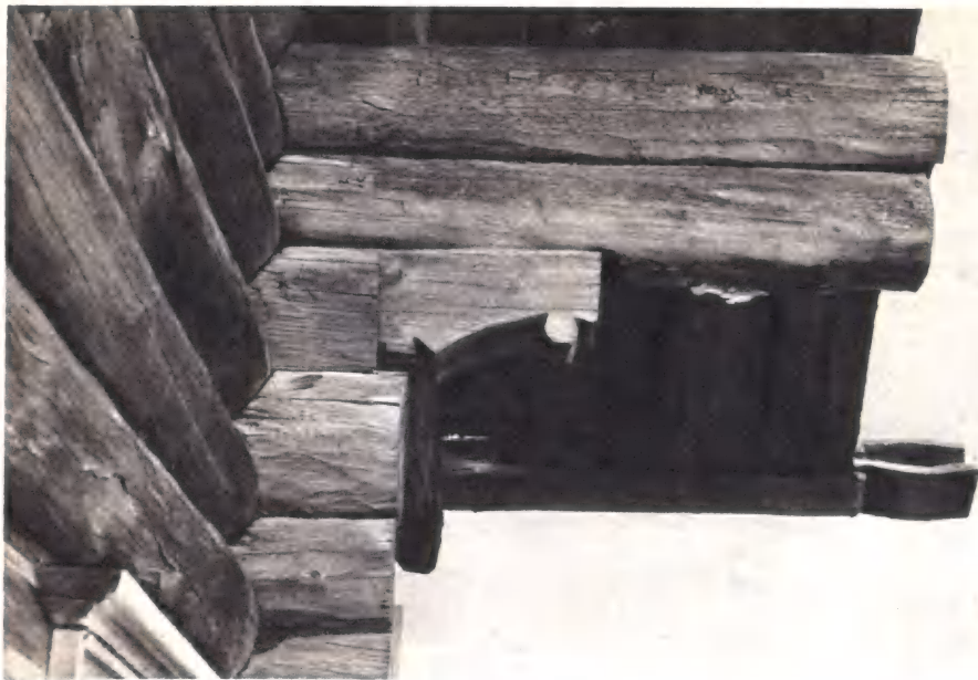
Выпуски бревен — помочи — поддерживают широкие свесы кровель.
