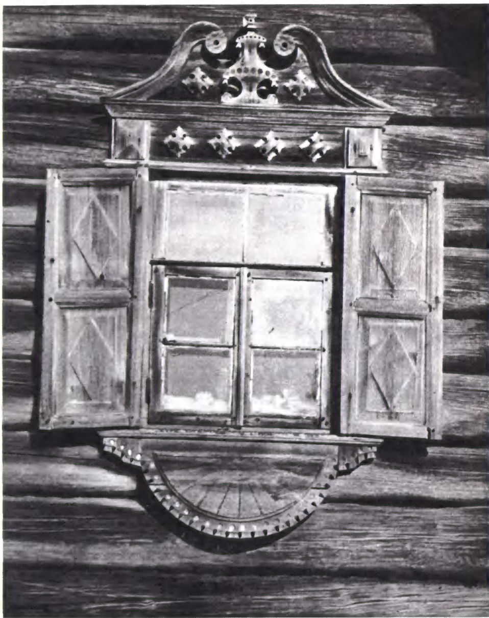
Наличник с волютами над окном — предмет особой заботы заонежского строителя.
