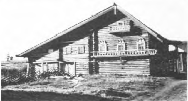
Жилые дома деревни Ямка (фрагменты застройки)
