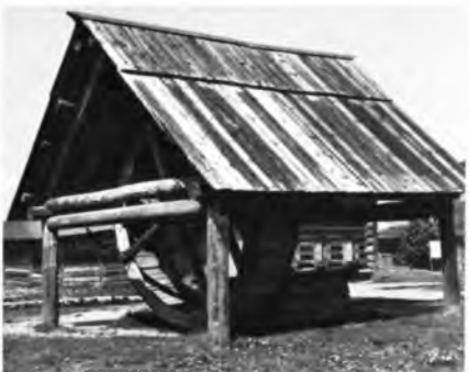
«Ступальный» колодец в музее деревянного зодчества в Суздале
