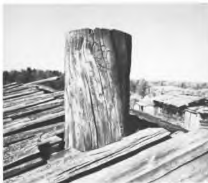
Труба в летнем доме в деревне Хорнима (снаружи и внутри)
