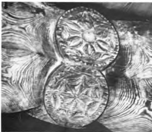
Розетки на балках Васильевской церкви
