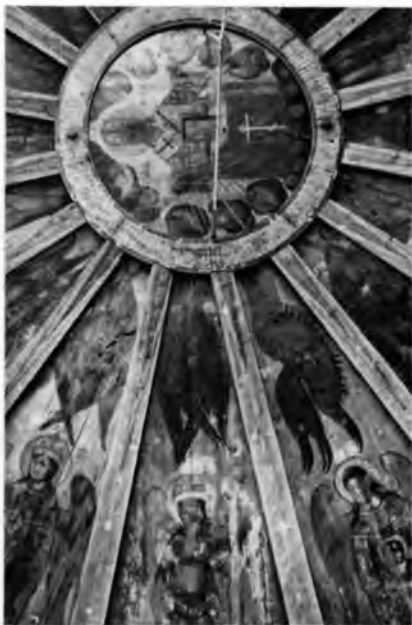
Покровская церковь близ Вытегры. Фрагмент потолка-«неба»
