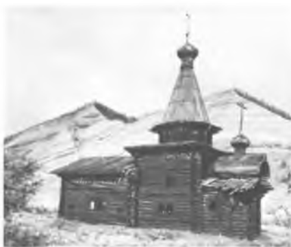
Спаская церковь Зайииверского острога. Вид с юга
