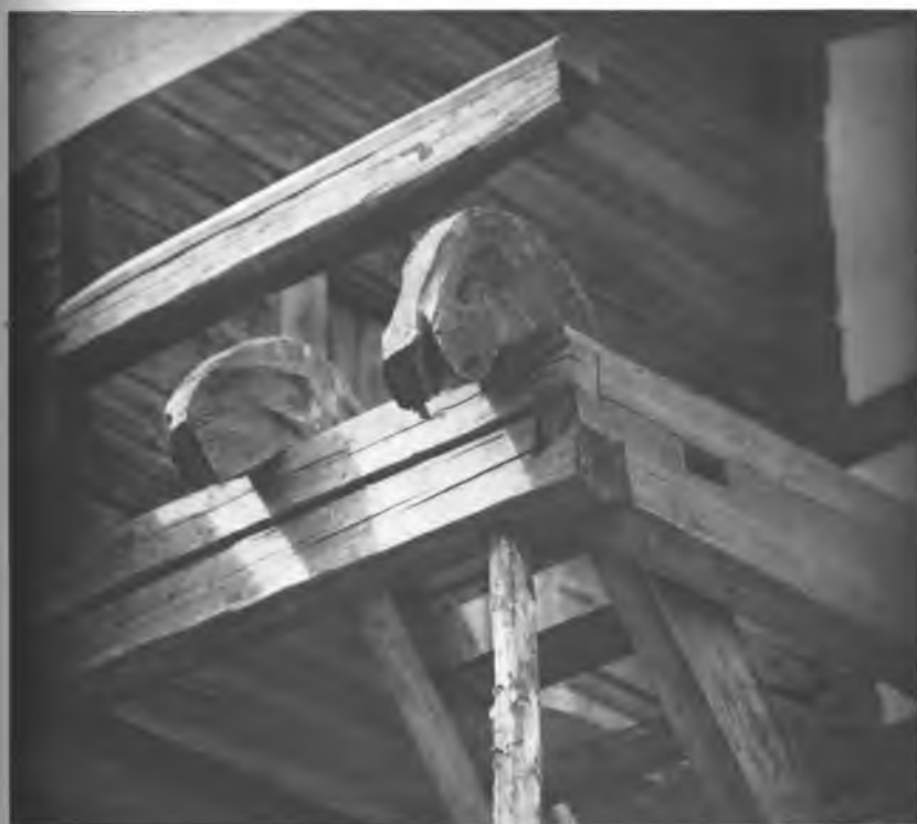
Мельница-столбовка в музее «Малые Корелы». Верхнее крепление лестницы
