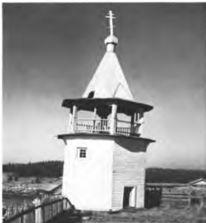
Колокольня Никольской церкви в селе Ковда
