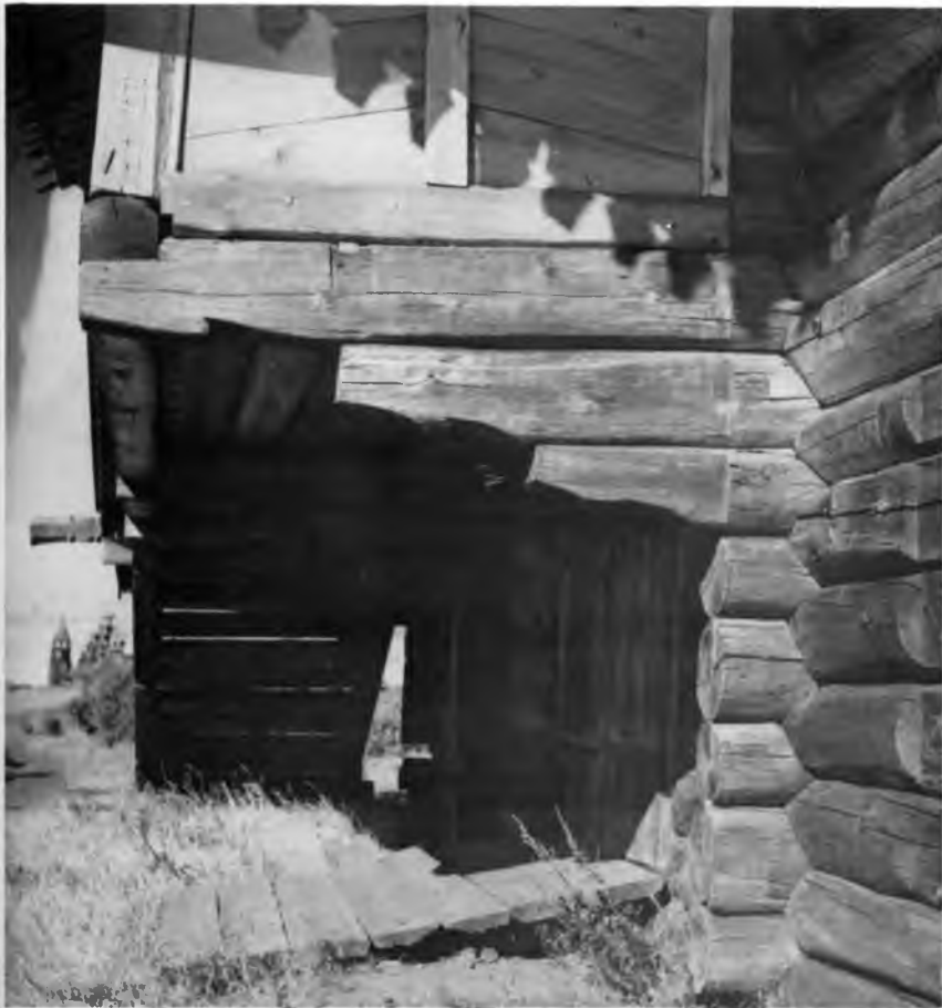
Часовня из деревни Кавгора в музее «Кижский дом». Выпуски-крюштейны, поддерживающие крыльцо
