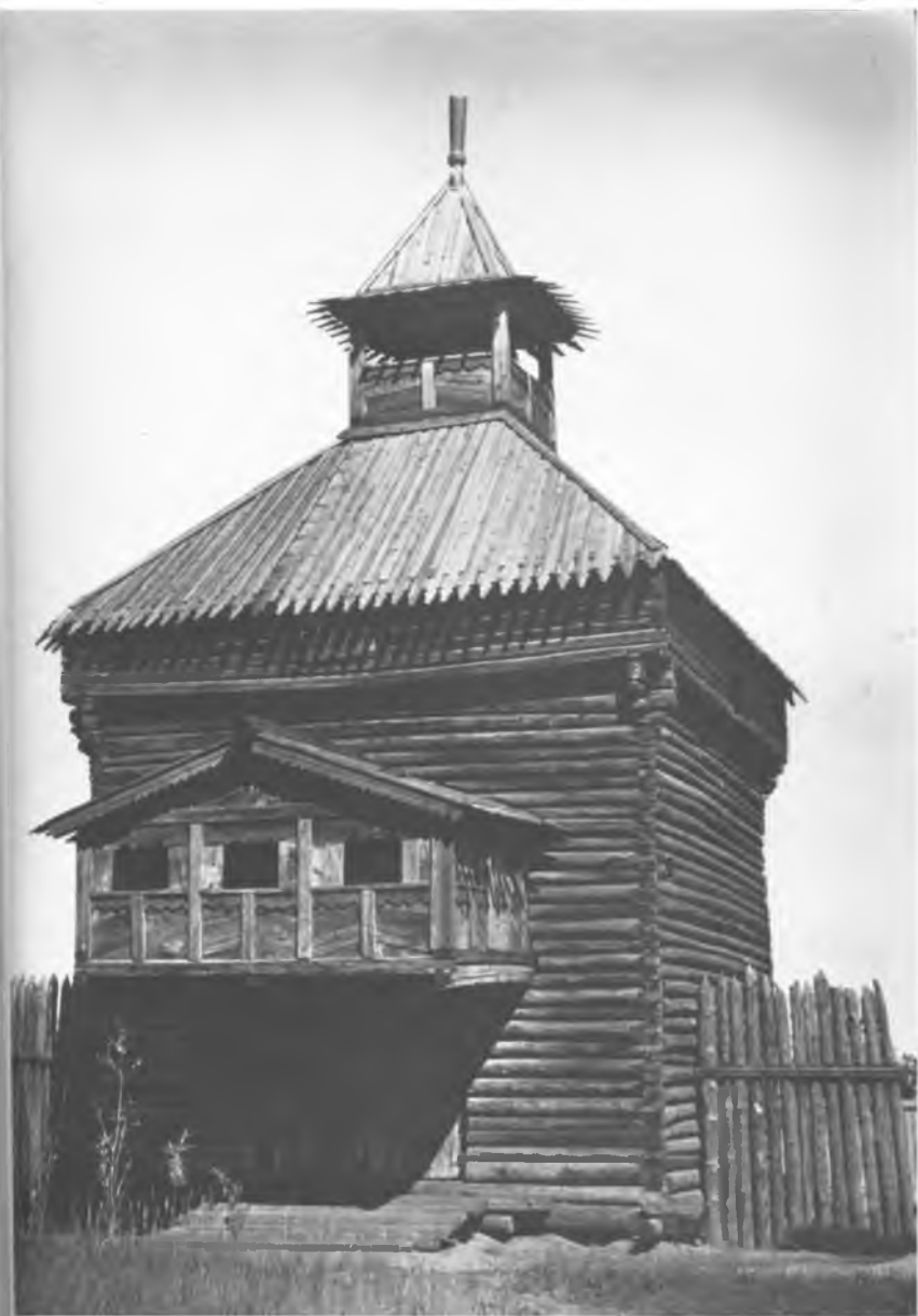
Башня Якутского острога после реставрации. Фото Е. А. Оповниковой
