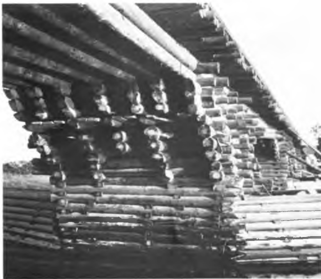
Мост через реку Кена. Фрагмент опоры-бъяка.
