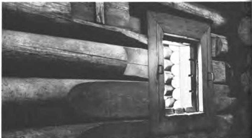
Владимирская церковь в селе Белая Слода. Юго-западное окно (снаружи и внутри)
