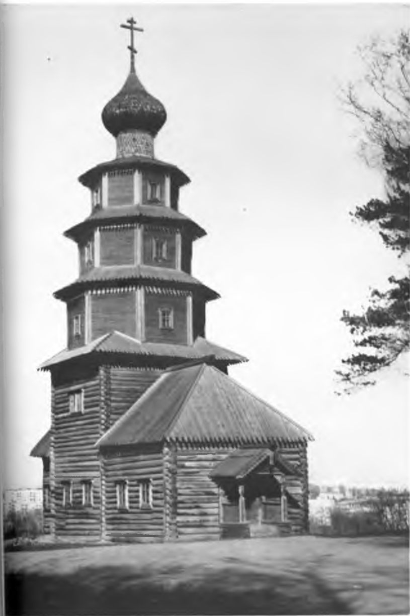
Тихвинская церковь в Торжке. Вид с северо-запада. Фото Е. А. Ополонниковой
