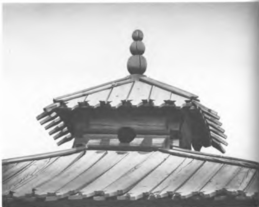
Баня Братского острога в Коломенском. Часть кровли
