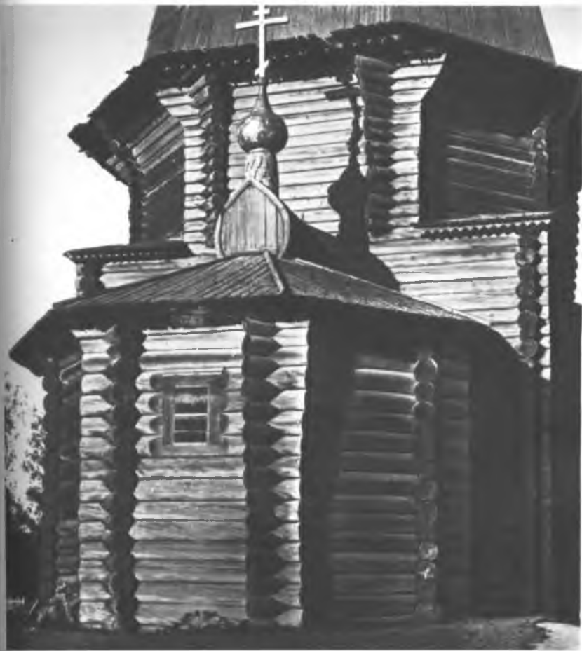
Дмитриевская церковь в селе Верхняя Уфтюга. Часть восточного фасада
