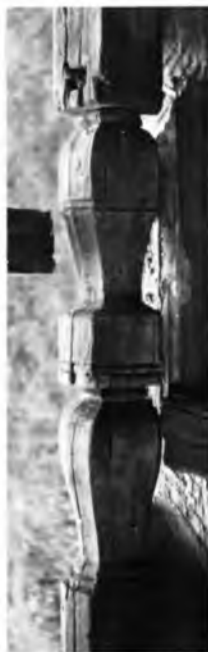
Часовня в деревне Авдотьино. Столб первоначального крыльца, спрямленный под обшивкой
