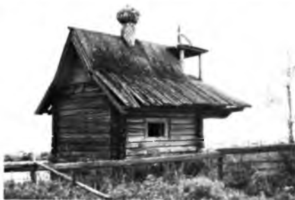
Часовня в деревне Аюдовино. Вид с северо- востока. Фото Е. А. Ополонниковой
