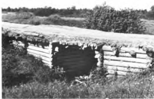
Мосты через реку Большая Сивдаля (приток Кены). Фото Е. А. Ополюшиковой
