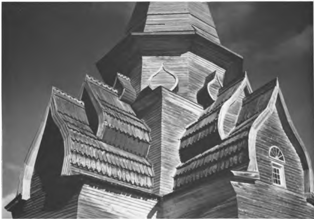
Успенская церковь в Варзуге. Ярус- кокошники
